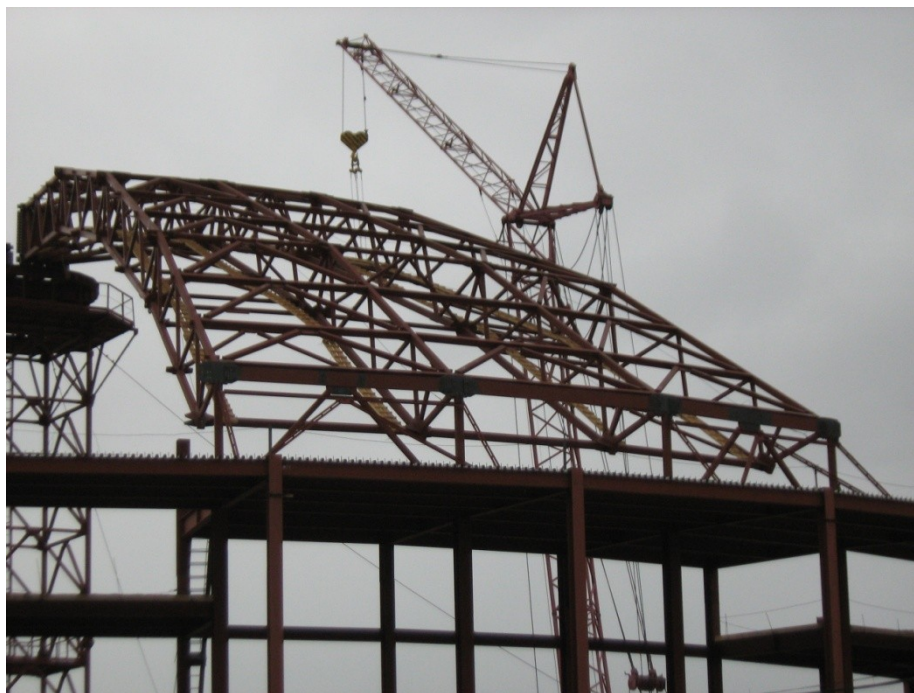
Рис 2. Схема арочного покрытия здания
