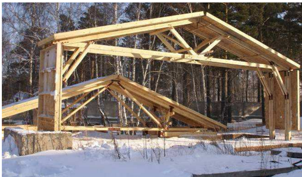
Рисунок 1 - Рамнопанельная блок-секция
