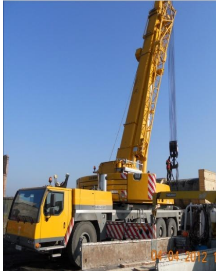
Рис. 2. Мобильный автокран Liebherr LTM 1130
