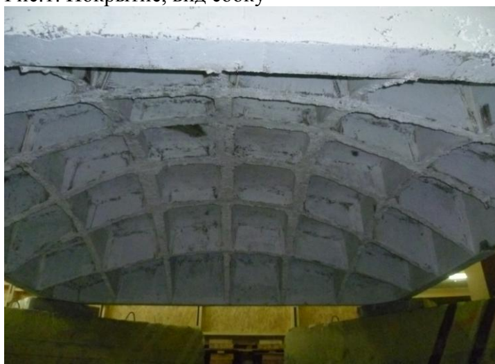
Рис.2. Покрытие, вид снизу
