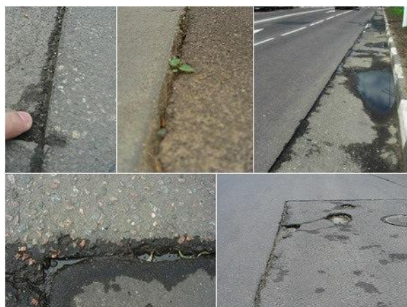
Рисунок 3 – Участки устройства покрытия без применения дорожной битумно-полимерной ленты
