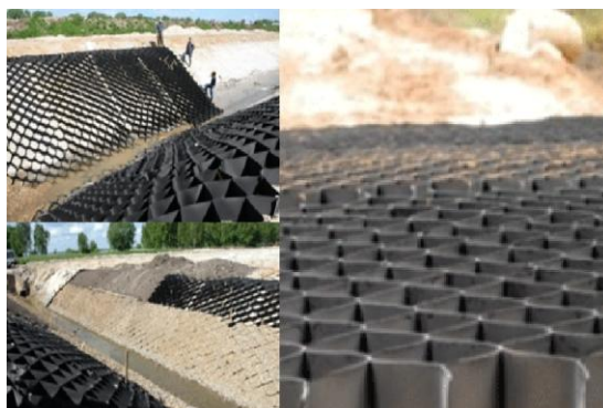
Рисунок 6 – Объемная георешетка и ее применение.
