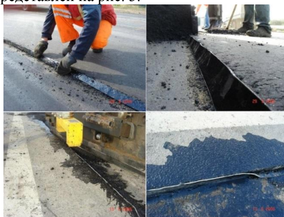
Рисунок 2 – Технология для герметизации трещин и швов дорог
