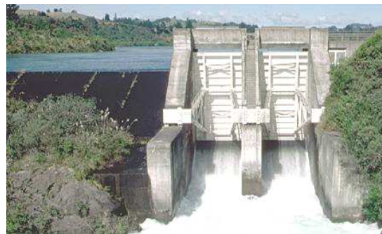
Плотина на реке Вайкато (Новая Зеландия)
