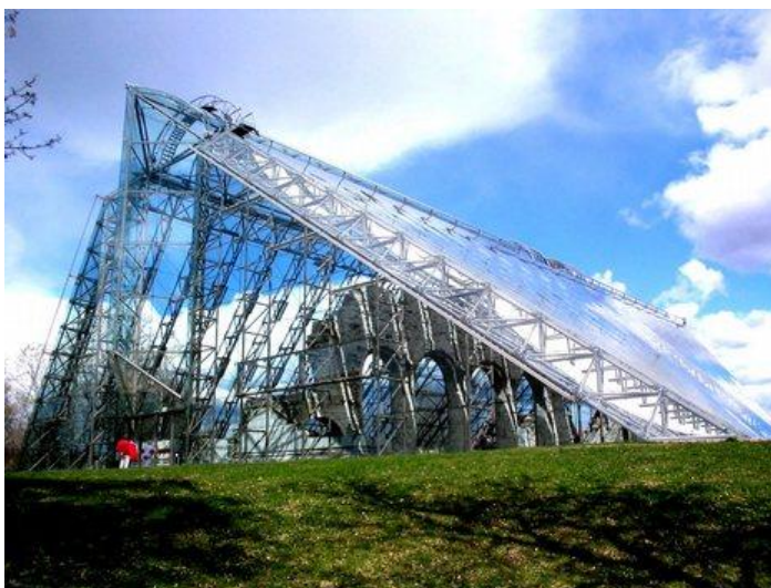
Рис. 4. Защитное сооружение над руинами собора в Хамаре (фото Т. Frogner)
