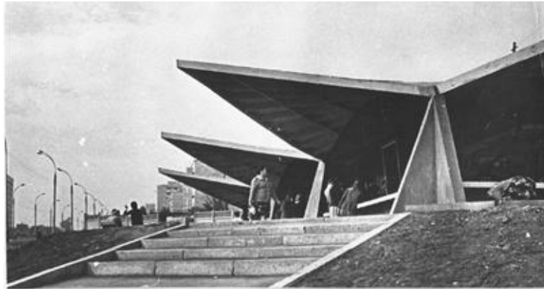
Рис. 3. Сборное составное гиперболическое покрытие рынка размером 36,0х24,0м.
